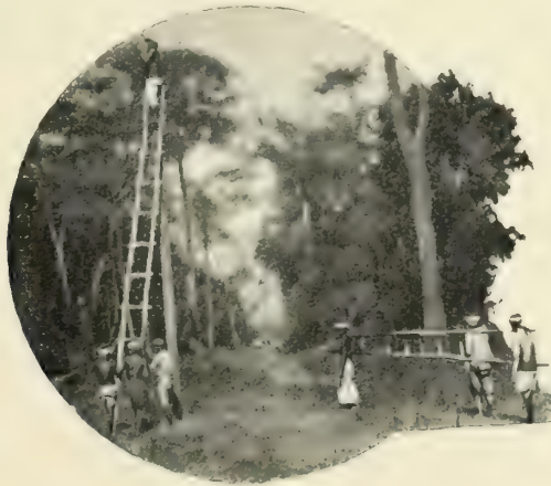
Fig. 76. Travaux du télégraphe.
